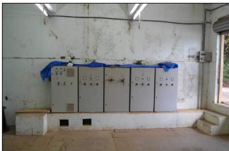
Foto 6: Painel elétrico para controle de operação da captação de água bruta. Fonte: Maximus Environmental, 2017.
