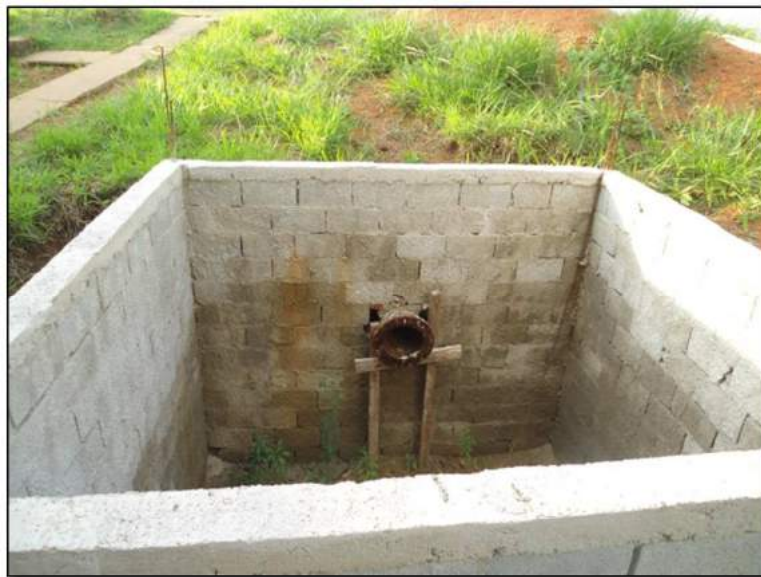
Foto 11: Adutora de 300 mm – linha nova a ser interligada que abastecerá a região central. Fonte: Maximus Environmental, 2014.
