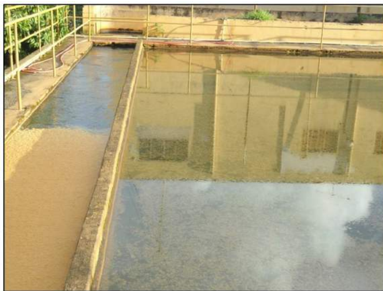
Foto 32: Canal de entrada e floclador do módulo da 1ª etapa. Fonte: Maximus Environmental, 2017.
