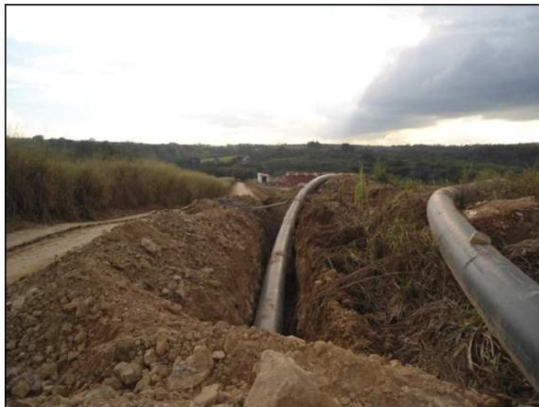
Foto 53: Vista da linha de recalque em PEAD DE 500mm – PN 8 SDR 21. Fonte: Maximus Environmental, 2014.
