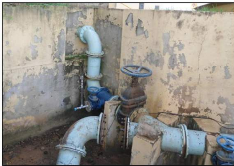
Foto 9: Adutora de 250 mm – abastece os reservatórios do Santo Rizzo. Fonte: Maximus Environmental, 2017.
