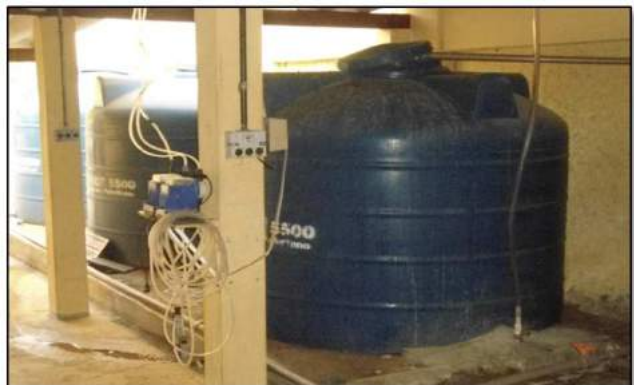
Foto 38: Reservatórios de Policloreto de Alumínio na ETA. Fonte: Maximus Environmental, 2017.
