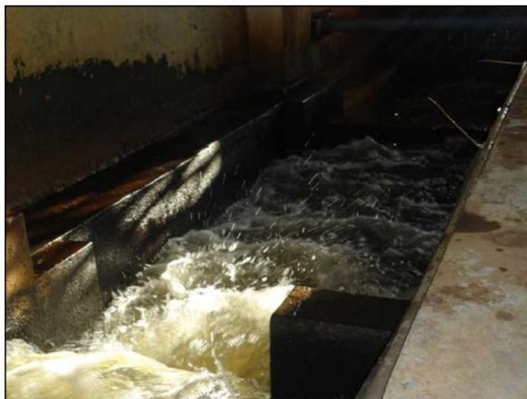
Foto 25: Canal de entrada. Fonte: Maximus Environmental, 2017.
