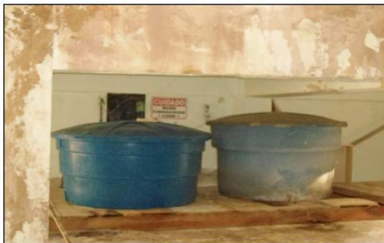
Foto 39: Reservatórios de Policloreto de Alumínio na ETA. Fonte: Maximus Environmental, 2017.
