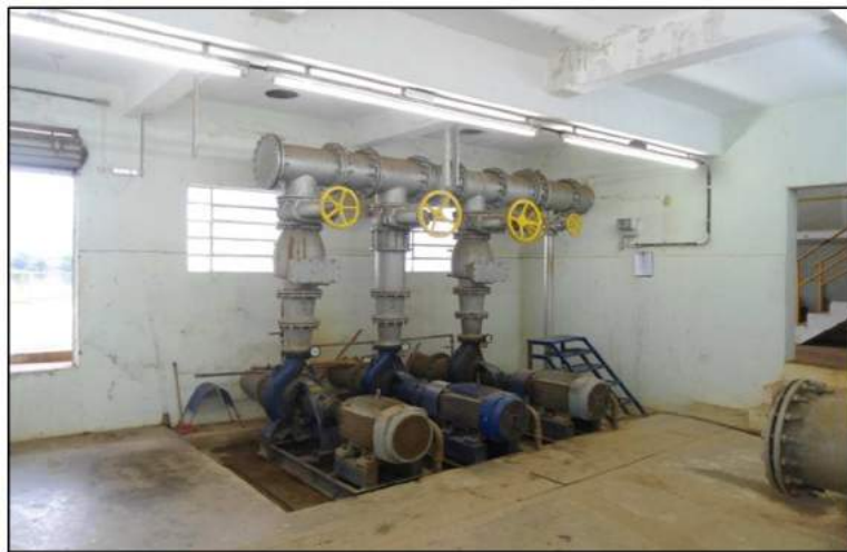
Foto 5: Captação de água bruta. Fonte: Maximus Environmental, 2017.
