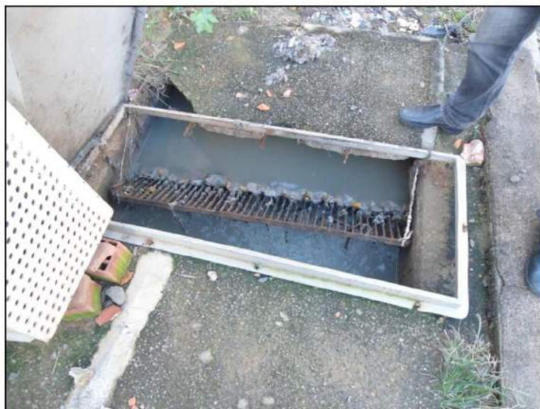
Foto 57: Gradeamento. Fonte: Maximus Environmental, 2014.
