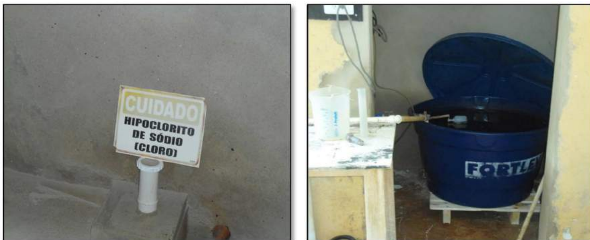
Foto 40: Sistema de abastecimento de Hipoclorito de Sódio na ETA. Fonte: Maximus Environmental, 2017.
