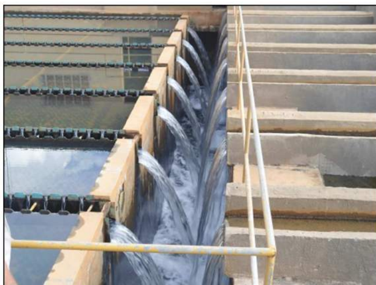
Foto 35: Saída do decantador do módulo da 1ª etapa para canaleta comum aos decantadores que encaminha a água para os filtros. Fonte: Maximus Environmental, 2017.
