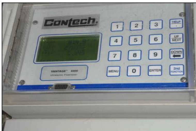
Foto 4: Medidor de vazão de água bruta. Fonte: Maximus Environmental, 2017.
