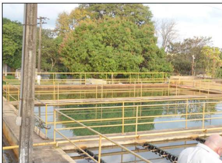
Foto 33: Vista do floclador do módulo da 1ª etapa. Fonte: Maximus Environmental, 2017.
