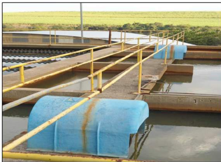
Foto 28: Floculação do módulo da 2ª Etapa. Fonte: Maximus Environmental, 2017.
