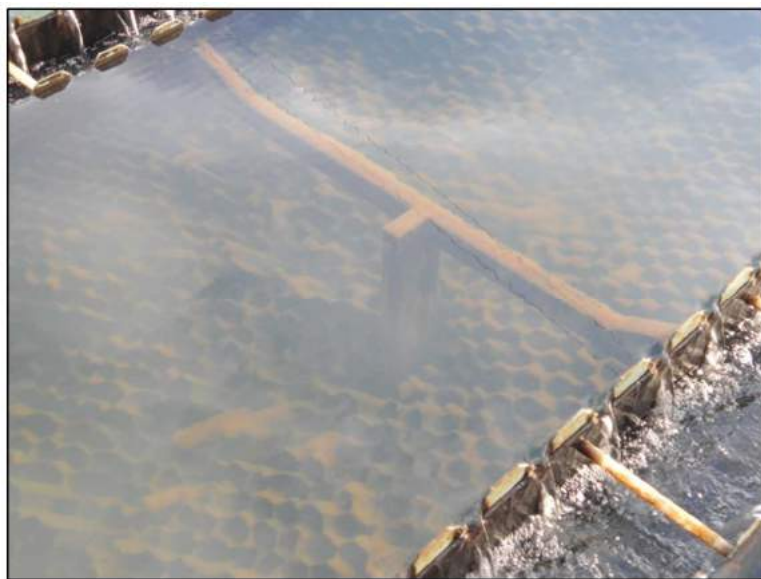
Foto 34: Vista da fixação dos módulos tubulares do decantador do módulo da 1ª etapa. Fonte: Maximus Environmental, 2017.
