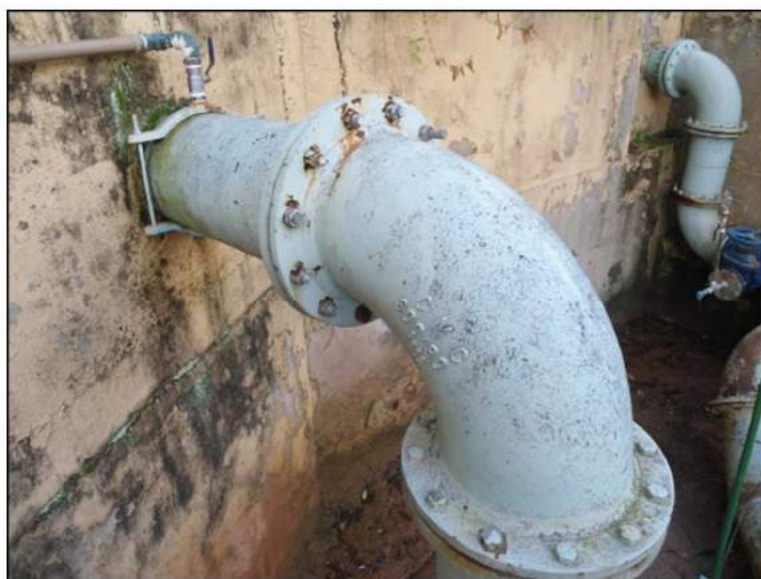
Foto 10: Adutora de 300 mm – abastece o centro, via a EEAT do Bosquinho. Fonte: Maximus Environmental, 2017.
