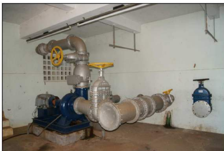
Foto 37: Sistema de retrolavagem dos filtros. Fonte: Maximus Environmental, 2017.
