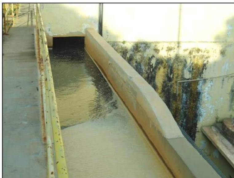
Foto 27: Canal de entrada da água no módulo implantado na 2ª etapa. Fonte: Maximus Environmental, 2017.
