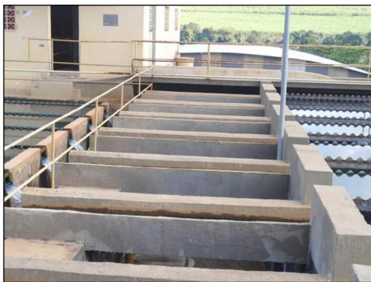
Foto 31: Saída do módulo da 2º etapa na canaleta comum ao módulo da 1ª etapa para seguir para os filtros. Fonte: Maximus Environmental, 2017.
