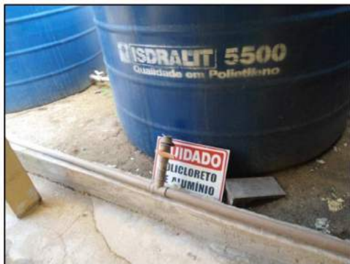
Foto 38: Reservatórios de Policloreto de Alumínio na ETA. Fonte: Maximus Environmental, 2017.
