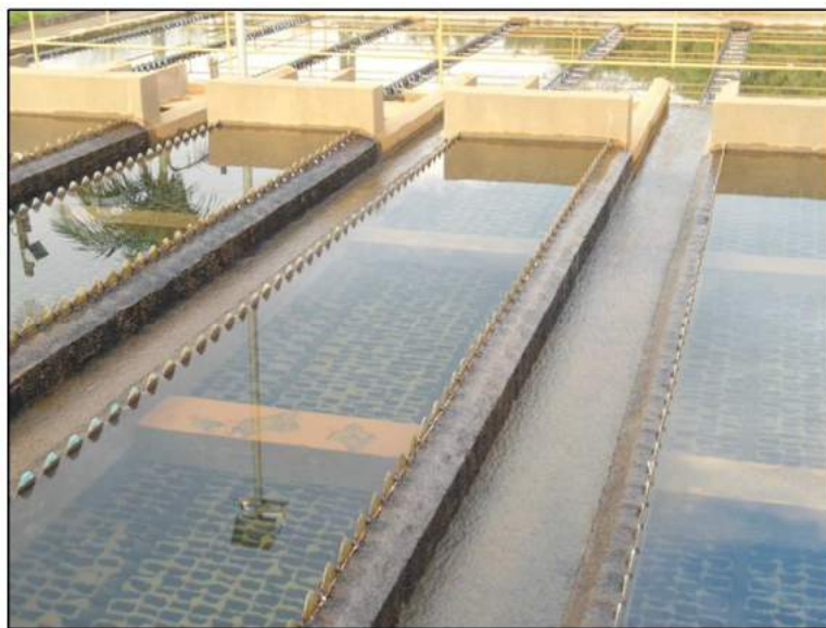
Foto 30: Decantação no módulo da 2ª Etapa, com módulos tubulares verticais. Fonte: Maximus Environmental, 2017.
