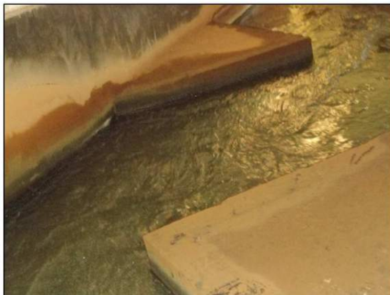
Foto 26: Chicana de contato. Fonte: Maximus Environmental, 2017.
