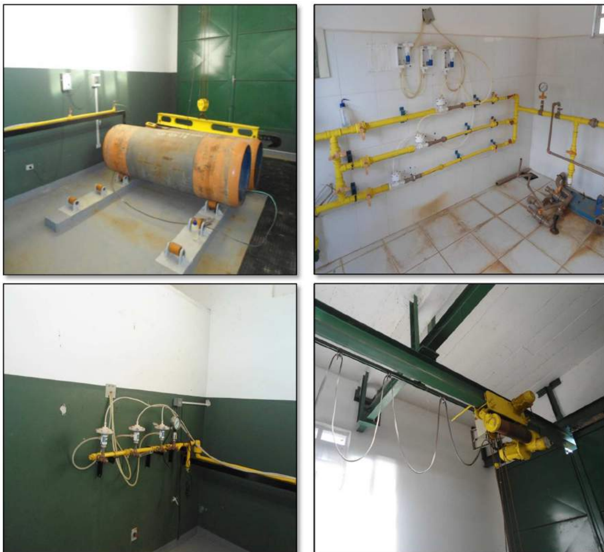
Foto 41: Sistema de abastecimento de Cloro gás. Fonte: Maximus Environmental, 2017.
