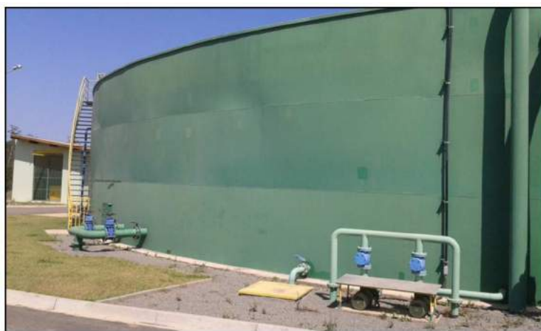
Foto 48: Vista do UASB e casa de desinfecção. Fonte: Maximus Environmental, 2014.
