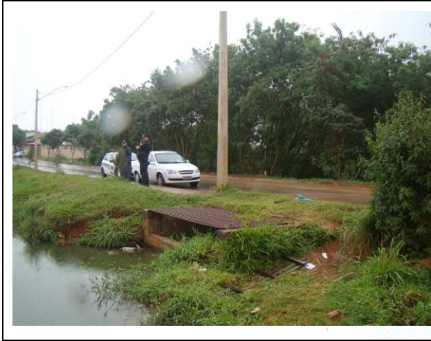
FOTO 29. Vista geral de rua sujeita a processos de inundação. Segundo moradores as inundações são lentas e graduais. Nesse trecho, a água atinge cerca de 1,0 m de altura.
