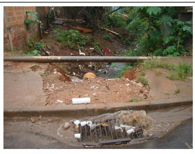
FOTO 20. Vista geral de córrego e sistemas de controle das águas de superfície. Notar que os processos erosivos afetam calçamento e boca de lobo.
