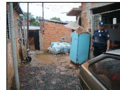
Vista de trecho que é afetado pela elevação das águas do ribeirão.
