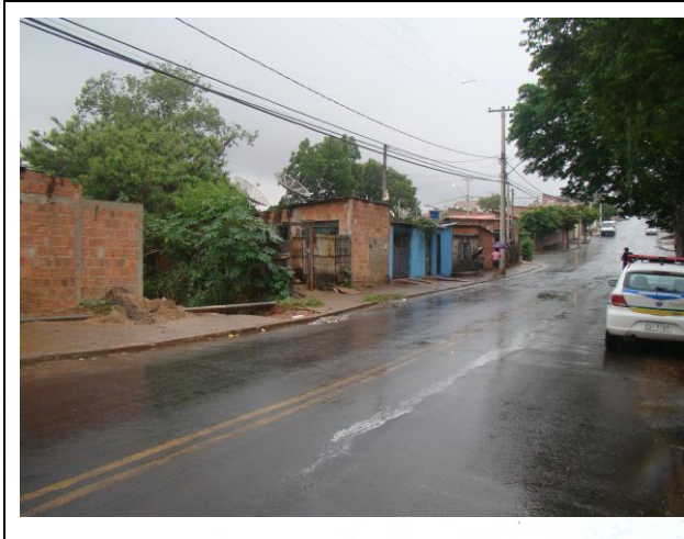
FOTO 25. Vista geral de rua sujeita a processos de inundação. Segundo moradores, as inundações são lentas e graduais. Nesse trecho, a água atinge cerca de 1,0 m de altura.
