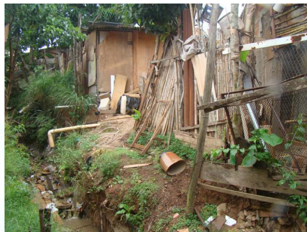
FOTO 38. Detalhe dos taludes marginais e do padrão construtivo das moradias.
