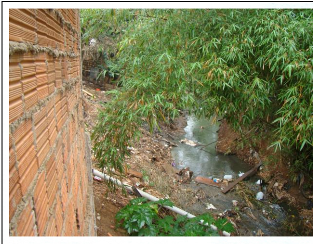
FOTO 15. Vista geral de pequeno córrego que provoca inundações e erosões marginais ao longo do seu curso.
