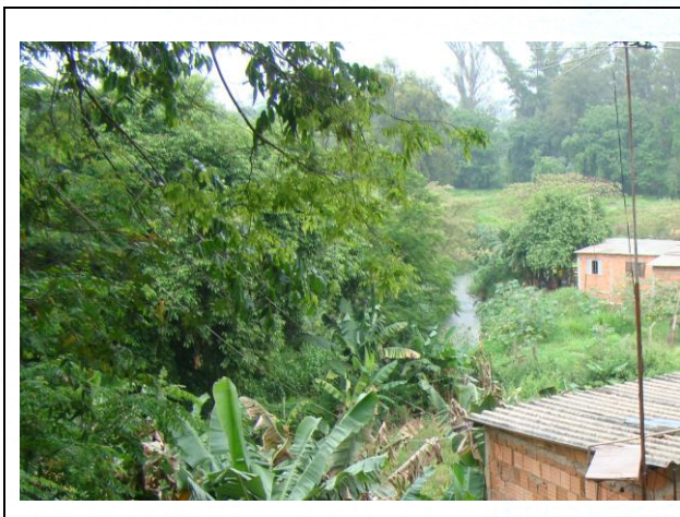
FOTO 51. Vista geral de área sujeita a processos de inundação. Notar proximidade de moradias e dimensões do canal.
