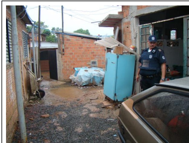
FOTO 53. Vista de trecho que é afetado pela elevação das águas do ribeirão. Notar densidade das ocupações, ausência de infraestrutura e padrão construtivo.
