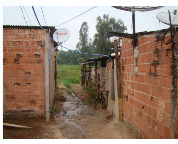
FOTO 60. Vista geral de área sujeita a inundações.
