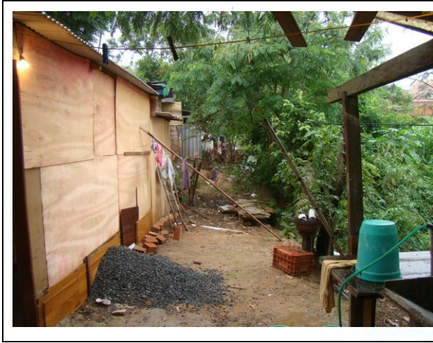
FOTO 13. Vista geral de renque de moradias sujeitas a processos de inundação e solapamento de margem. Segundo moradores, as inundações são lentas e graduais. Nesse trecho, a água atinge cerca de 2,5 m de altura.
