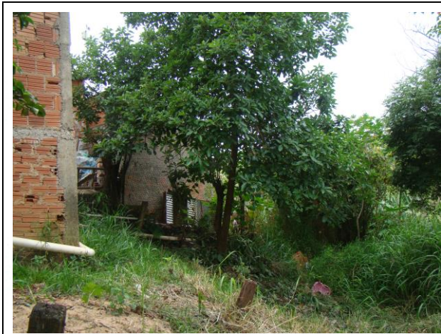
FOTO 1. Vista de talude de aterro em setor de risco de deslizamento. Notar: padrão construtivo, proximidade da moradia em relação à crista do talude e tubulações de PVC expostas.
