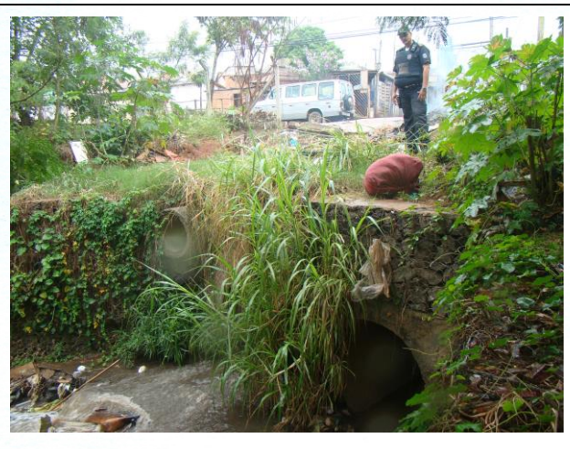
FOTO 24. Vista geral dos sistemas de condução e escoamento de água e contenção de taludes laterais (gabião).
