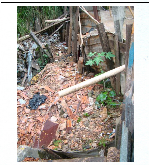
FOTO 3. Detalhe dos entulhos lançados em talude, mostrados na FOTO 2 . Notar tubulações lançando água em superfície.
