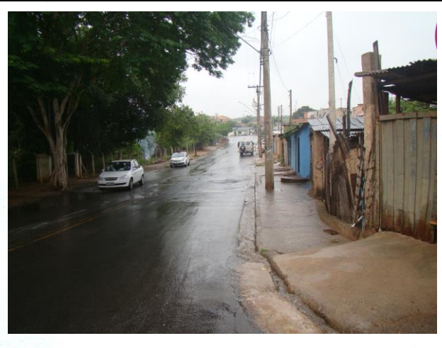
FOTO 26. Vista geral de rua sujeita a processos de inundação.
