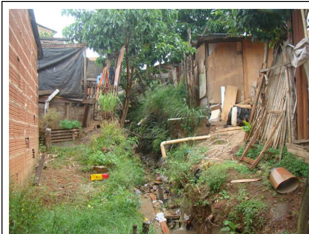
FOTO 37. Aspecto geral de moradias localizadas na proximidade de pequeno córrego.
