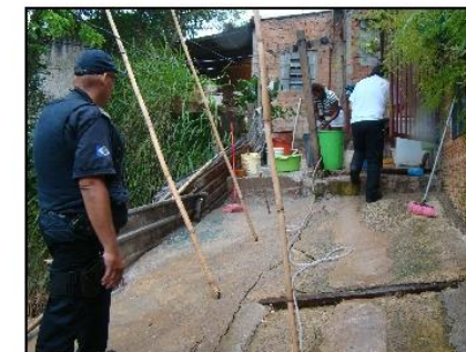
Vista geral de talude e moradia. Notar sinais de movimentação do terreno.
