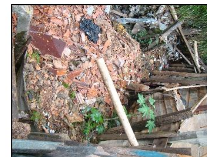
Detalhe dos entulhos lançados em talude.
