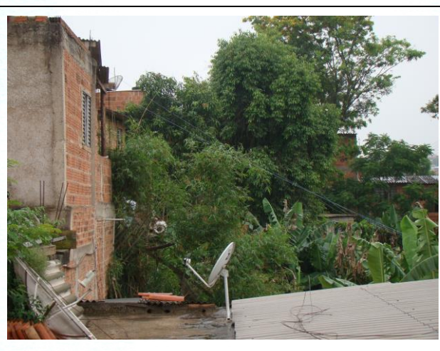
FOTO 8. Vista geral de moradias que ocupam a base e o topo de talude de corte, após escavação da encosta natural. Notar dimensões e proximidade das moradias.
