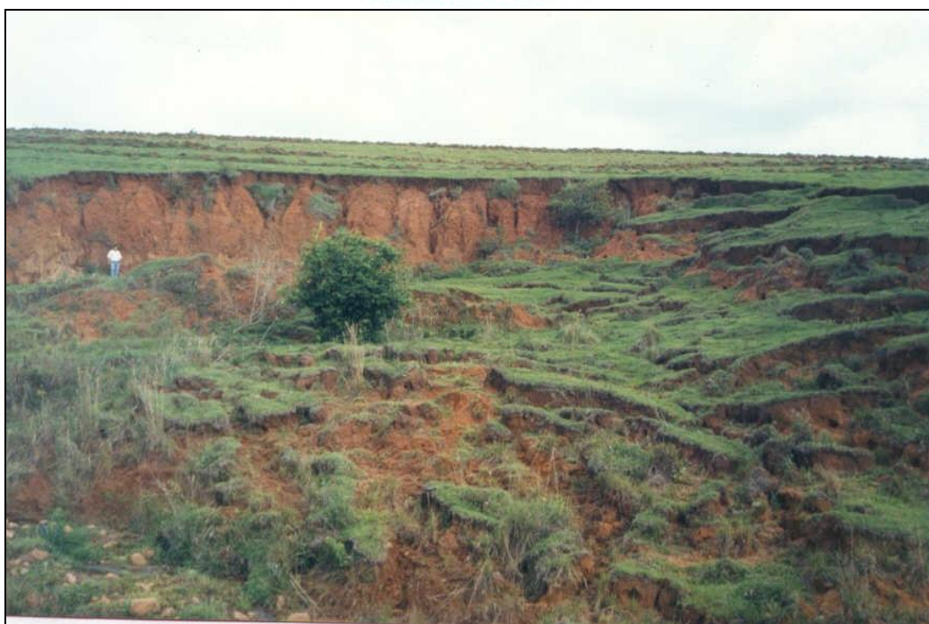
Figura 2 – Árvores inclinadas e degraus de abate indicando processos de rastejo (Ministério das Cidades, Instituto de Pesquisas Tecnológicas do Estado de São Paulo – IPT, 2007).
