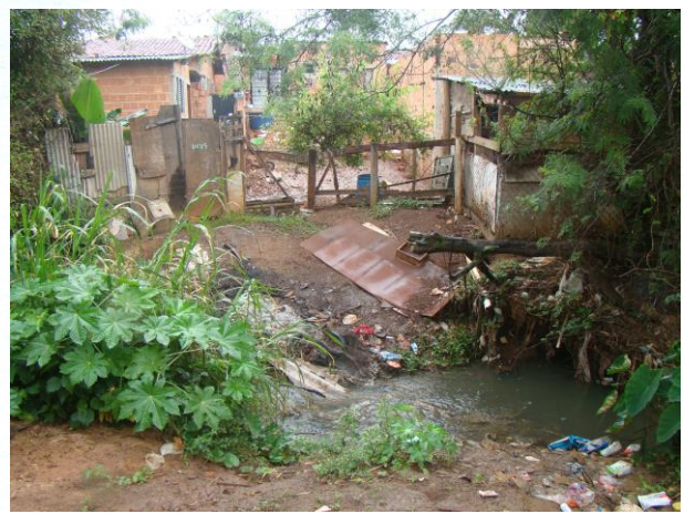
FOTO 16. Vista geral de renque de moradias localizadas em área sujeita a inundações. Notar padrão construtivo das moradias, dimensões dos taludes marginais e proximidade das moradias em relação ao córrego.
