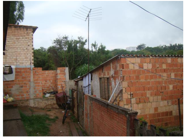
FOTO 46. Vista geral de moradias localizadas próximas à pequena drenagem. Os taludes, nesse trecho, apresentam menores dimensões.
