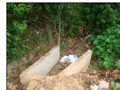
Aspecto de obra para controle das águas de superfície.
