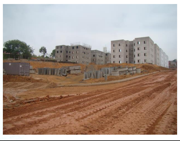
FOTO 42. Vista geral do conjunto habitacional sendo construído próximo à área avaliada. Notar solo exposto. A área deverá ser monitorada em função da concentração de água que provavelmente ocorrerá em função da impermeabilização dos terrenos e dos novos lançamentos.
