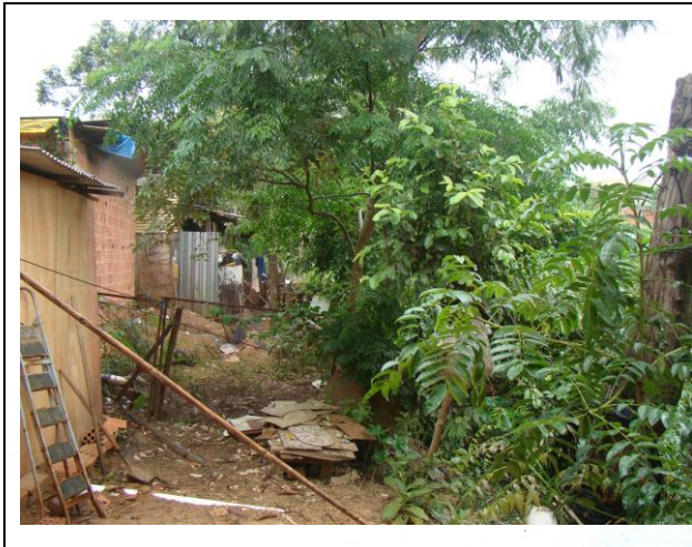
FOTO 09. Vista geral de moradias sujeitas a processos de inundação e solapamento de margem de córrego. Segundo moradores, as inundações são lentas e graduais. Nesse trecho, a água atinge cerca de 2,5 m de altura.
