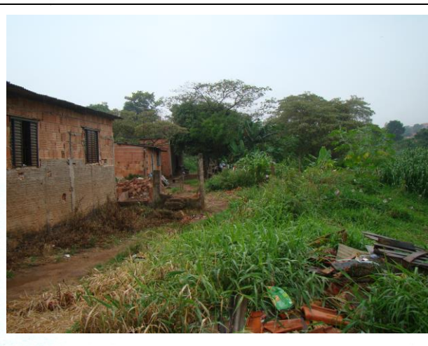
FOTO 58. Vista geral da planície fluvial. Notar que os taludes marginais apresentam pequenas dimensões.
