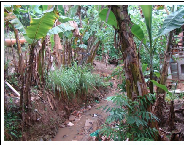
FOTO 43. Vista da drenagem em trecho mais a jusante do setor avaliado.
