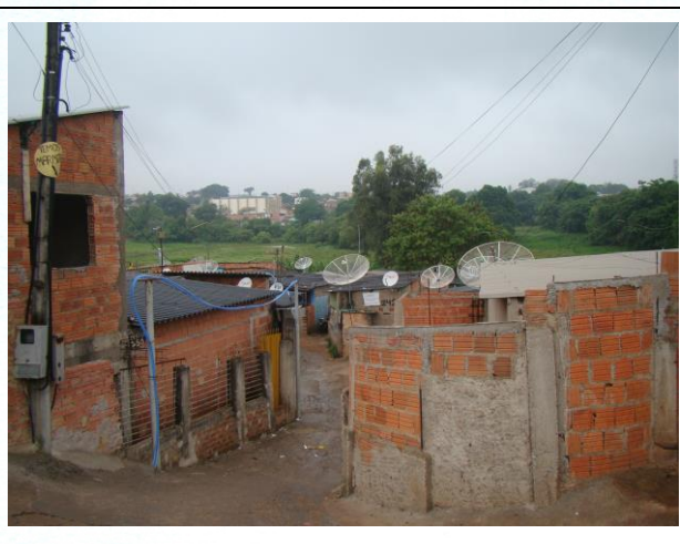
FOTO 20. Vista geral de área sujeita a inundações do ribeirão Três Barras (“Baguazinho”).
