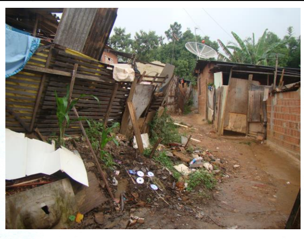
FOTO 18. Vista geral de moradias sujeitas a processos de inundação. Notar padrão construtivo e ausência de infraestrutura.
