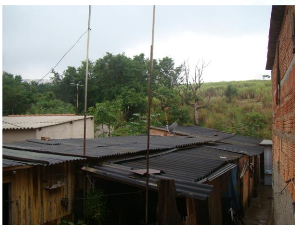
FOTO 47. Vista geral de moradias localizadas próximas à pequena drenagem. Os taludes, nesse trecho, apresentam menores dimensões.
