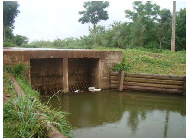
FOTO 30. Vista geral de vertedouro do lago mostrado na FOTO 27 .
