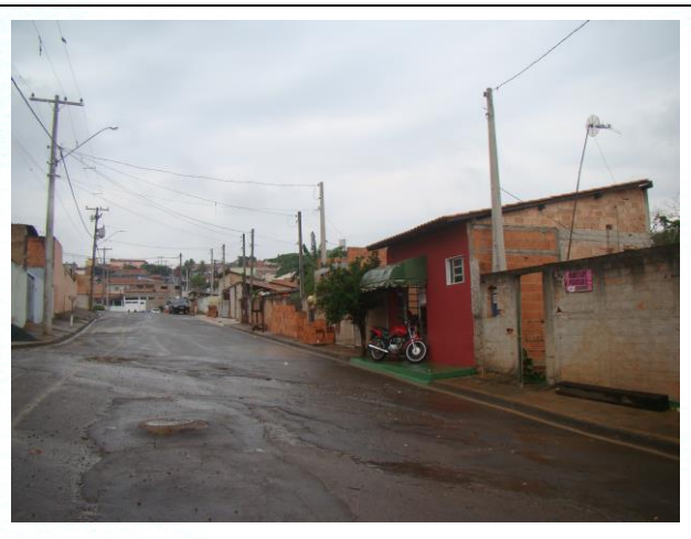
FOTO 44. Vista geral do renque de moradias localizadas próximas à drenagem (lado direito da imagem).
