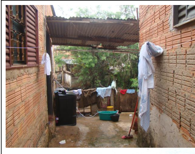
FOTO 17. Vista geral de moradias sujeitas a processos de inundação e solapamento de margem. Segundo moradores, as inundações são lentas e graduais. Nesse trecho, a água atinge cerca de 2,0 m de altura.
