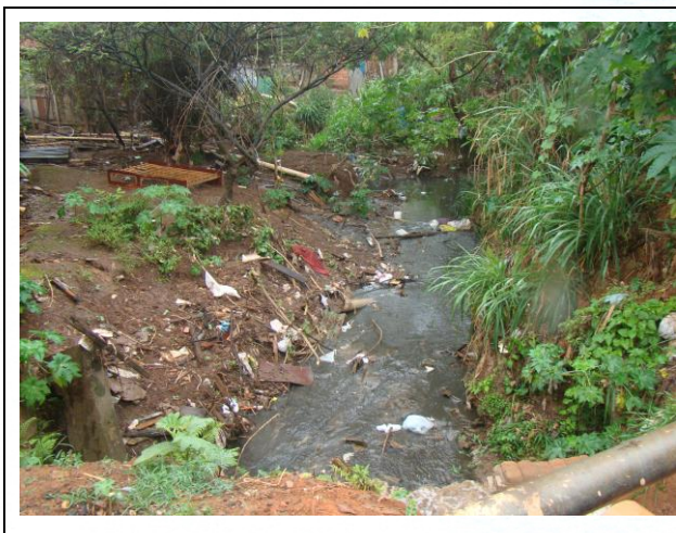
FOTO 19. Vista geral de pequeno córrego, denominado Córrego do Barreiro Amarelo. Notar dimensões dos taludes marginais e presença de lixo e entulho nesse trecho.
