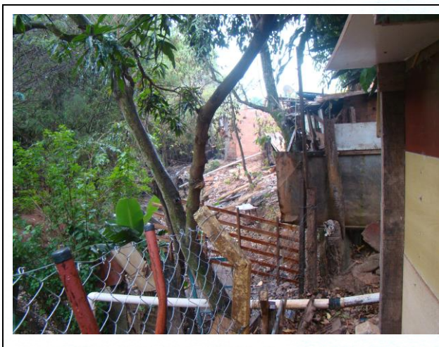
FOTO 11. Vista geral do fundo de moradias localizadas muito próximas a córrego de pequenas dimensões. Notar padrão construtivo e proximidade das moradias em relação ao topo do talude marginal.
