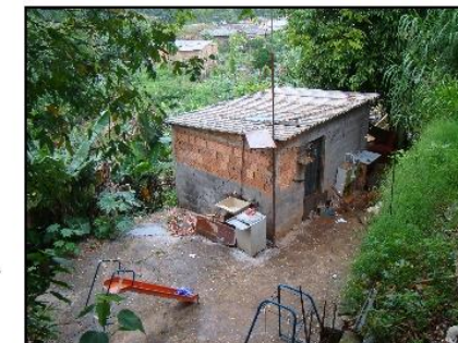
Vista geral de moradia localizada próxima a talude de corte.
