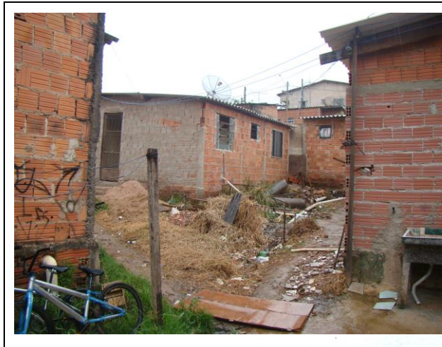
FOTO 61. Vista geral de moradias localizadas muito próximas das margens do ribeirão.
