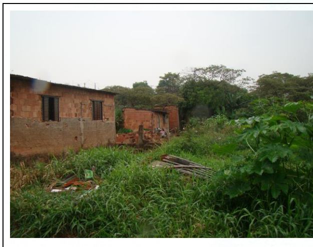
FOTO 55. Vista geral de área sujeita a processos de inundação do rio Cachoeira. Ressalta-se que há obra sendo executada, a jusante desse trecho, para melhorar o escoamento das águas.
