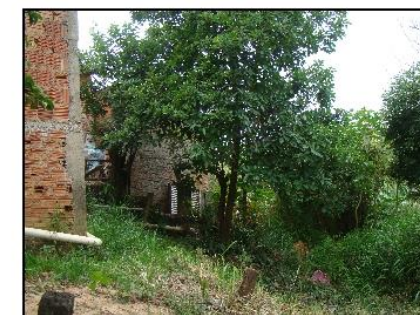
Vista de talude de aterro em setor de risco de deslizamento.
